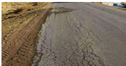
Fig. 5. Edge cracking
