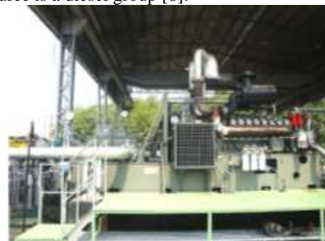
Fig. 4 Pumping group P100-A Pascuales - Tres Bocas [8]
